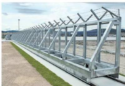
岩国空港のエアポートゲート、長さ103m、重量33トンの超大型ゲート
