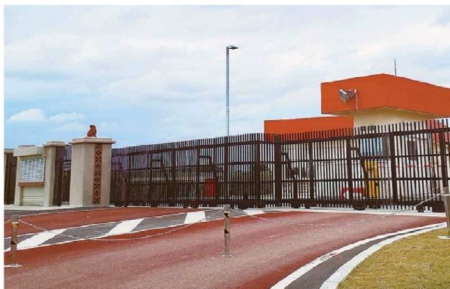
21年に沖縄県内の陸自施設に納入した門扉。「乗用車レベルの進入は十分防ぐことのできる『中強度』を実現している」（橋本部長）
